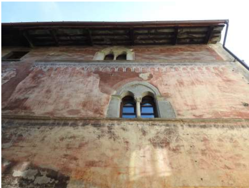
Détail de la Maison Clary - Photo de Luca Grande et de Simona Pons
