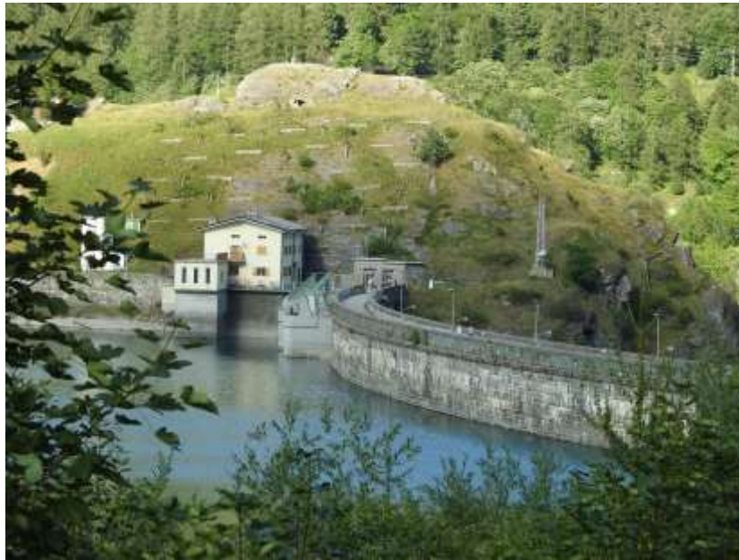
Barrage de Pontechianale dans l'hameau de Castello – Photo de Luca Grande et de Simona Pons
